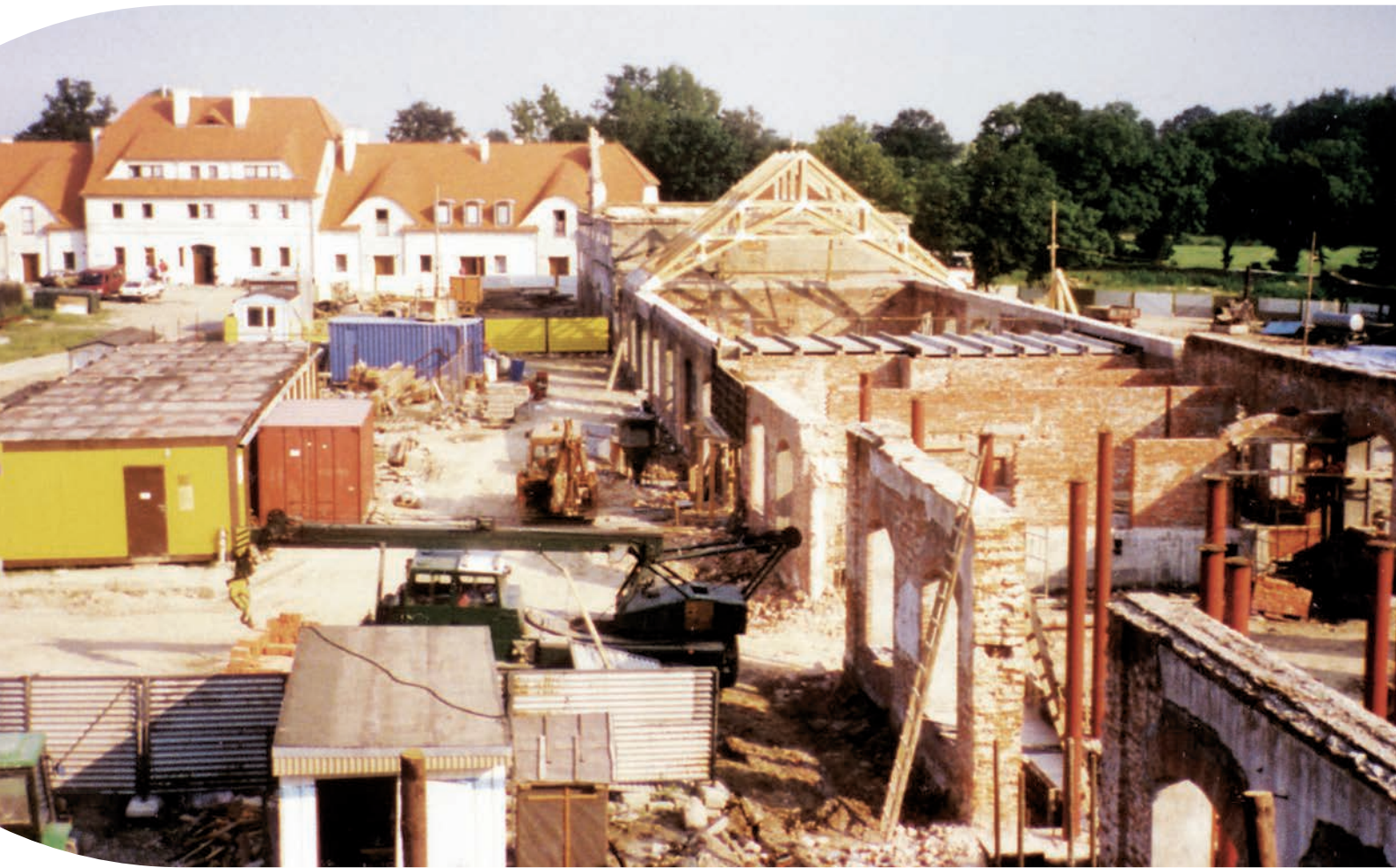
Bevor das ehemalige Gut zur Internationalen Begegnungsstätte wird, müssen die Gebäude von Grund auf saniert und umgebaut werden.
